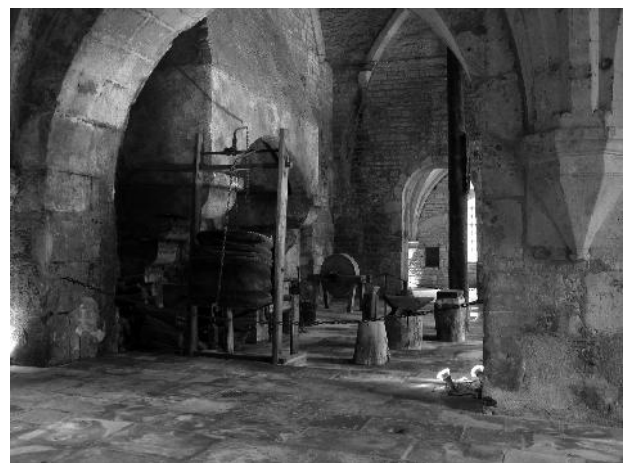
Forge de l'Abbaye de Fontenay. Ce bâtiment a été construit par les moines à la fin du XIIème siècle afin de travailler le minerai extrait à proximité. Photographie : G. NAUCHE, 2005.
